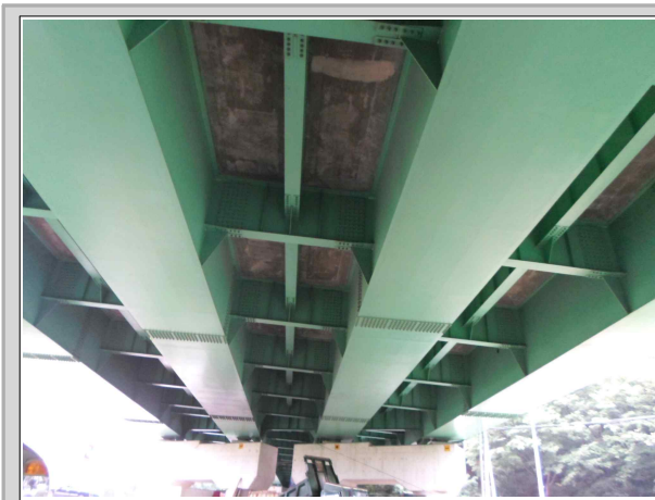
S1/ 바닥판 하면(A1→P1) 전경
