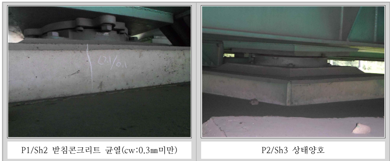
〈그림 2.1.8〉〈계속〉 받침장치 현황 및 손상사진
